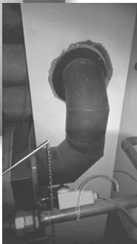
Špatné napojení na sopouch - netěsní a není čistitelný.
