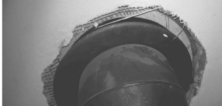
Špatné napojení na sopouch - netěsní a není čistitelný.
